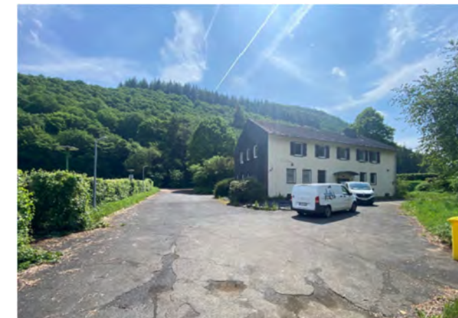
Leerstand Sozialgebäude am Bunker I
