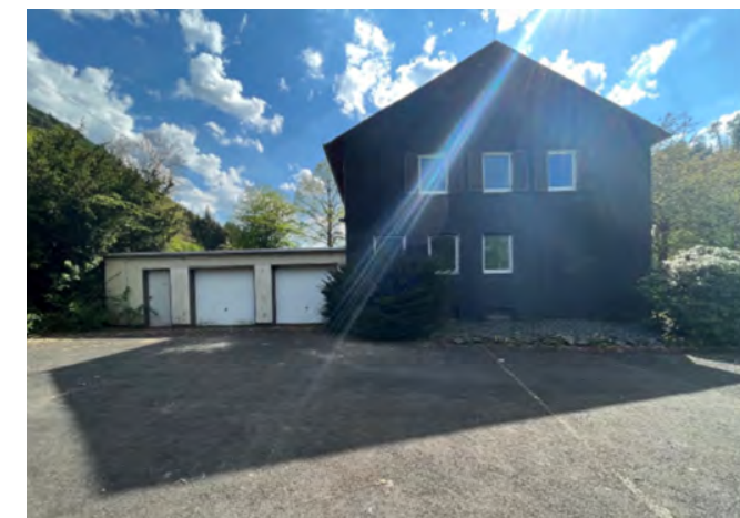
Leerstand Sozialgebäude am Bunker III
