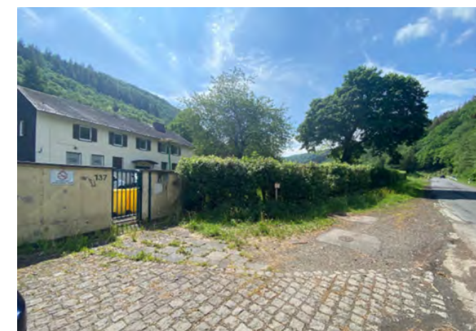
Leerstand Sozialgebäude am Bunker II
