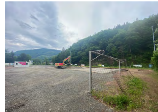
Kleinspielfeld im Bau I
